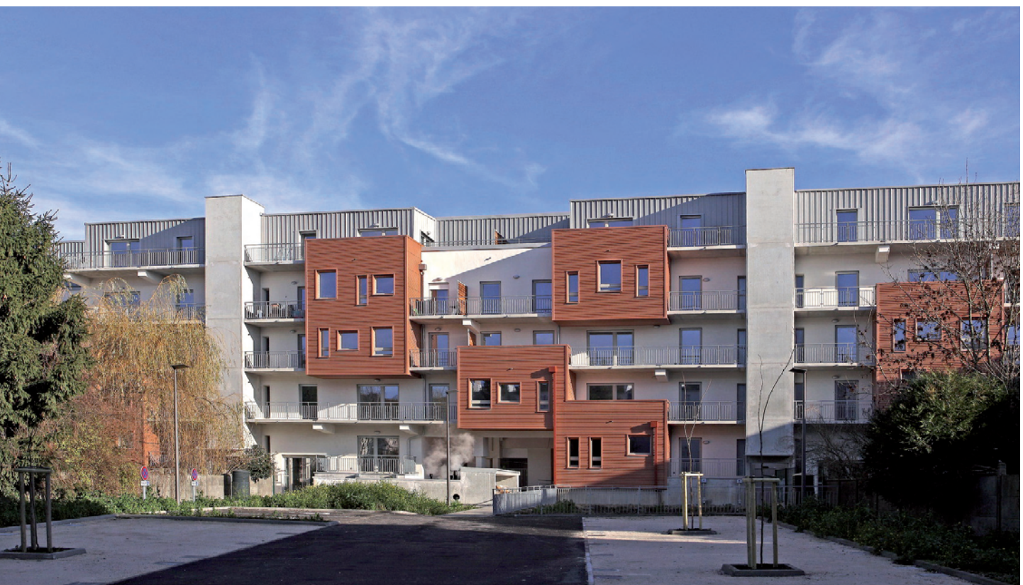
La nouvelle façade sur cour se rythme d'un jeu de pleins et de vides
